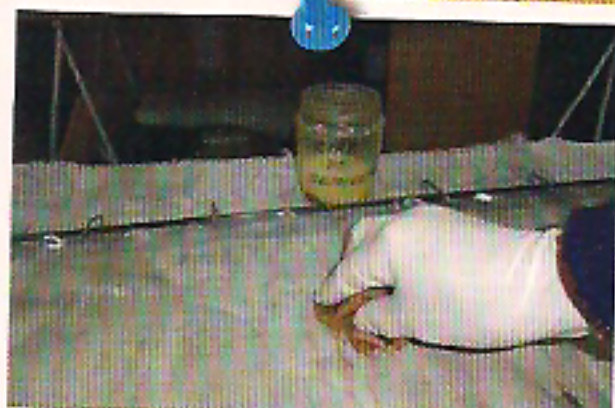
16 - La feuille de PVC est enduite si nécessaire de cire de démoulage afin que la résine de stratification ne colle pas dessus.
